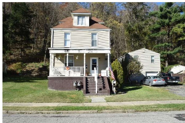
Fig. 42. 2343 Overbrook Avenue (OH-0001-0409), 2020.
