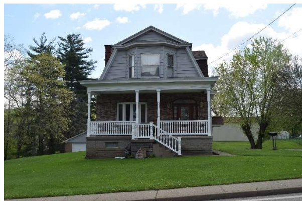
Fig. 27. 53 East Cove Avenue (OH-1362-0069), 2020.
