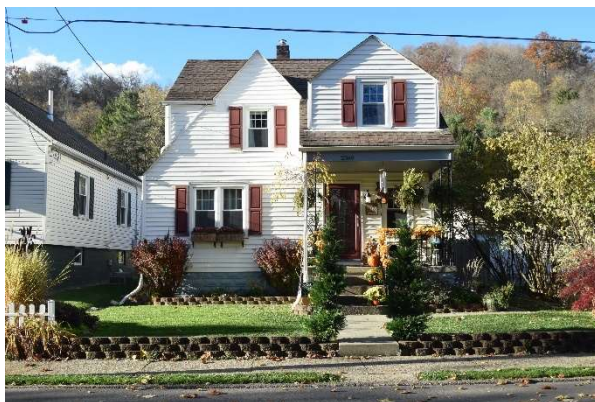
Fig. 41. 2369 Lumber Avenue (OH-1242), 2020.
